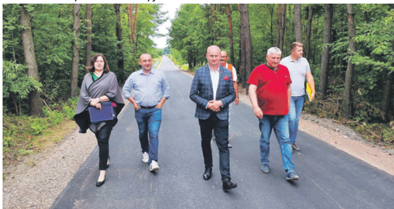
Przebudowana droga w Kruszewku
